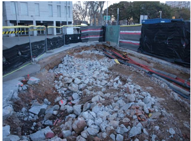
10. Desmuntatge fonaments formigó (UE 2, 3, 5)
