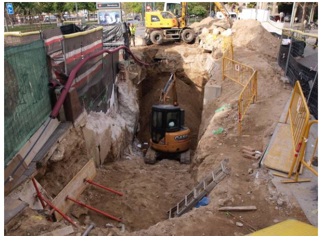
18. Fase de rebaixos (7)
