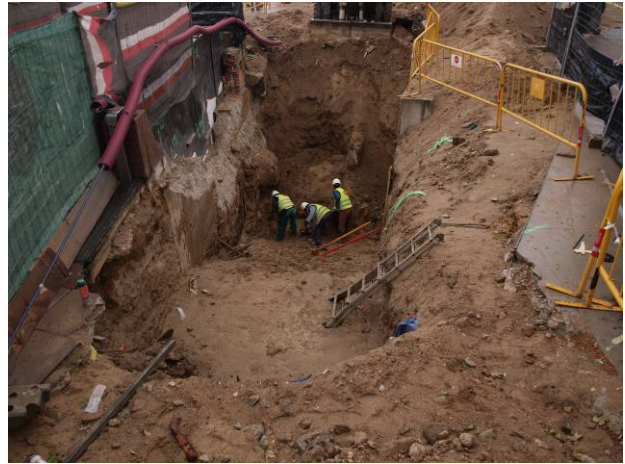
16. Fase de rebaixos (5)
