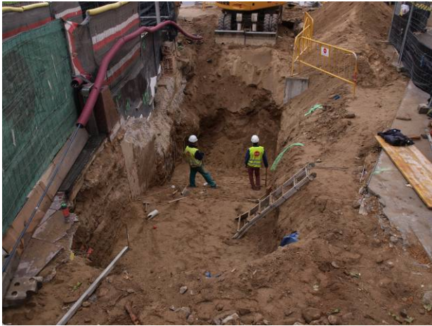
15. Fase de rebaixos (4)
