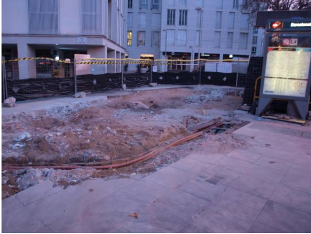
1. Inici dels treballs.
