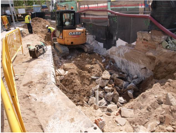
13. Fase de rebaixos (2)
