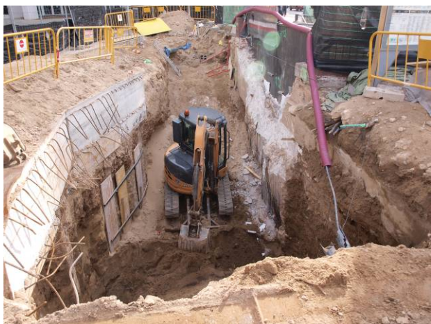
19. Fase de rebaixos (8)
