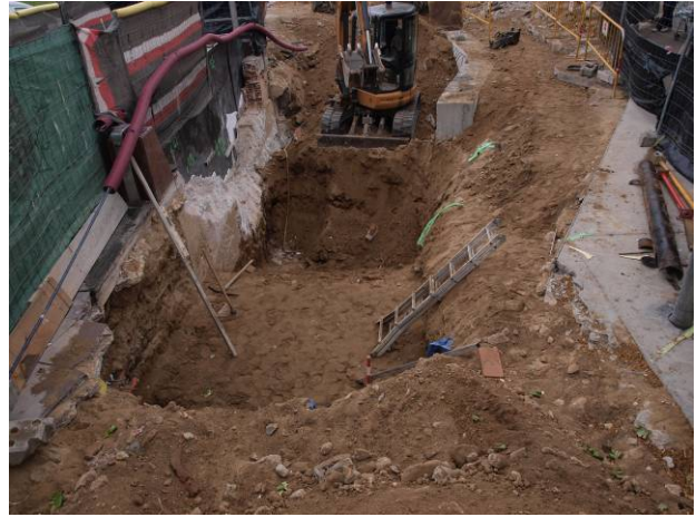
14. Fase de rebaixos (3)
