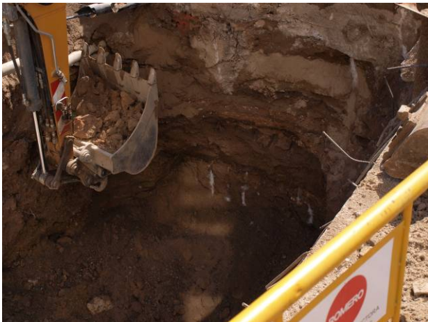
17. Fase de rebaixos(6).
